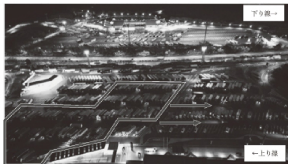
図 8-9 夜間照明の光量不足
